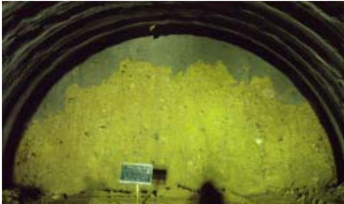
261km782m地点の切羽状況
